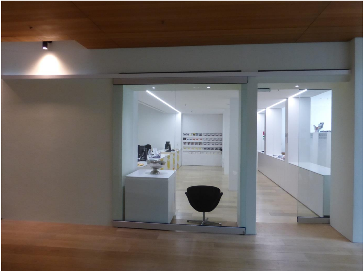
Bild 05 / Kassenmodus - Glastrennwand links bleibt geschlossen und Automatiktür ist in Funktion
