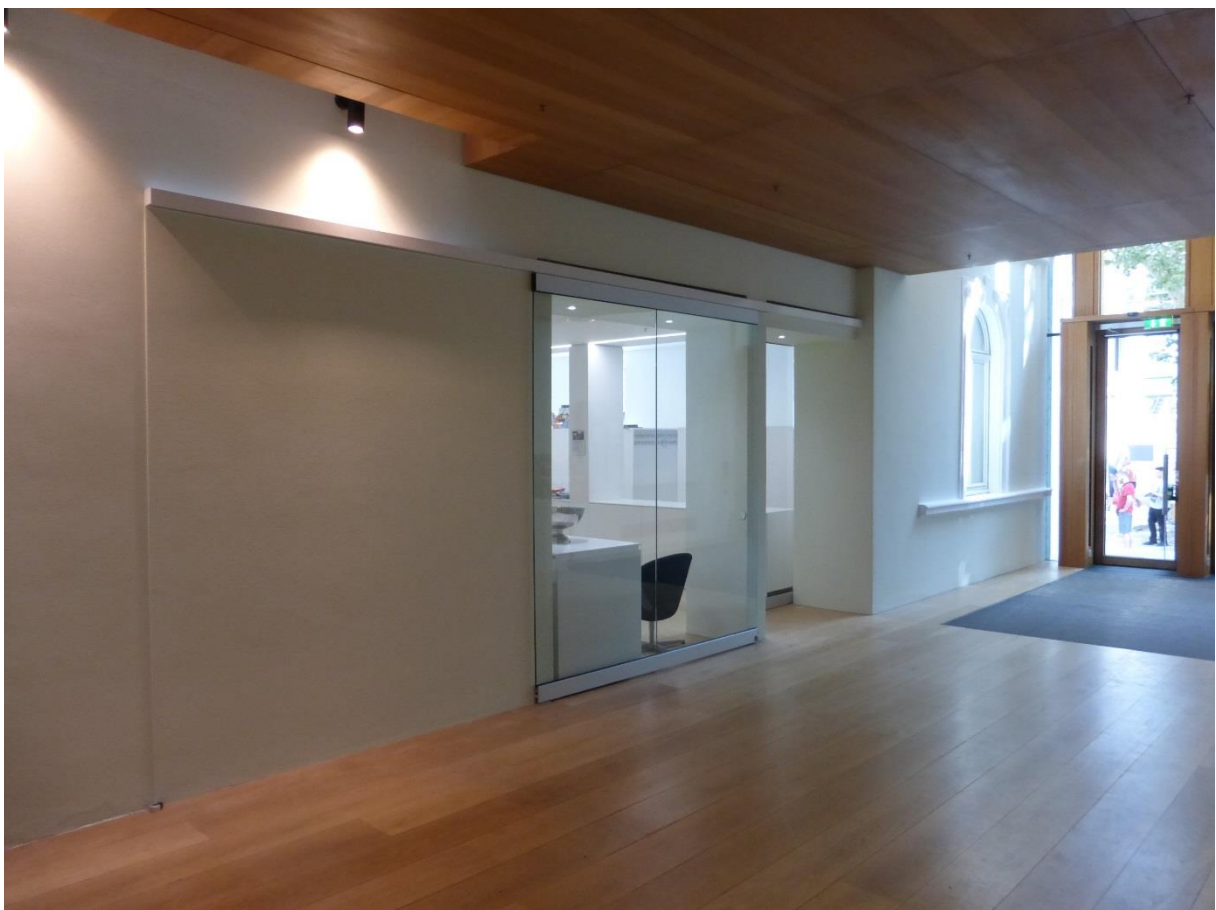
Bild 08 / Kassenmodus - Glastrennwand links bleibt geschlossen und Automattür ist in Funktion
