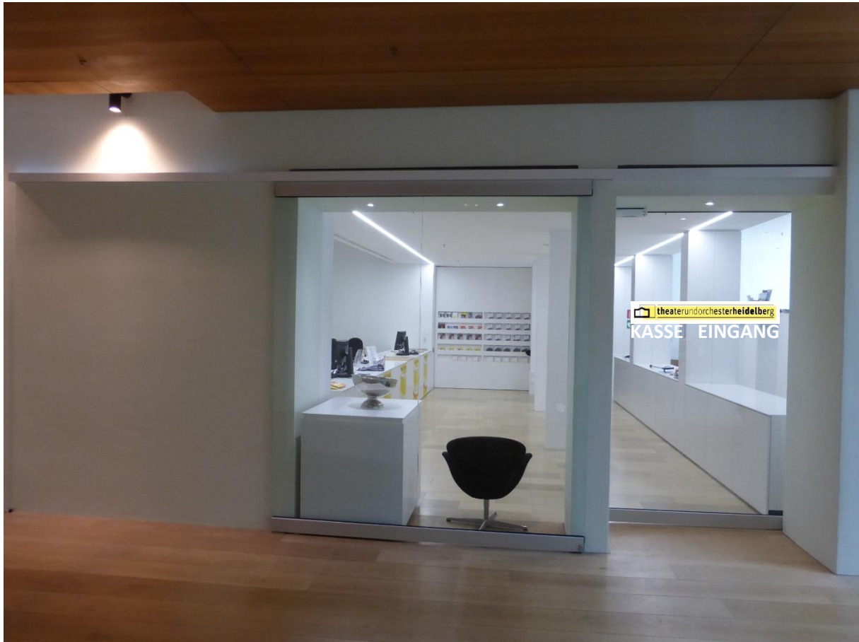
Bild 04 / Kassenmodus - Glastrennwand in Kassenposition
