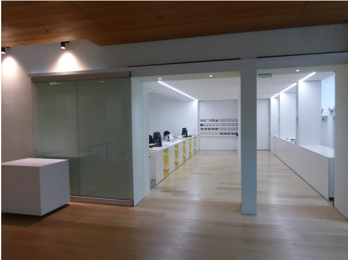
Bild 01 / Veranstaltungsmodus - Glastrennwand vollständig geöffnet
